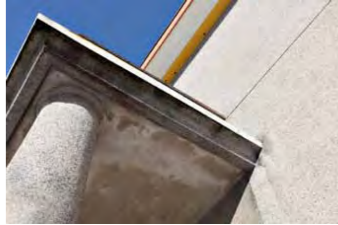
Sisääntulokatoksen terastirapattua betonijäsentelyä.
