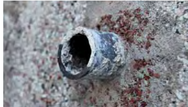
Keittiön komeron tuuletusputki pohjoisseinällä. Komeroa ei enää ole.
