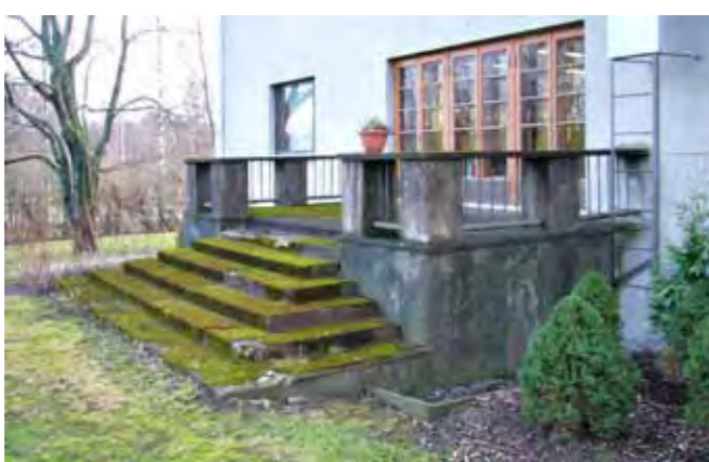
Ruokasalin lasiovet ja niiden edessä oleva terassi portaineen on kokonaisuudessaan alkuperäinen rakenne.
