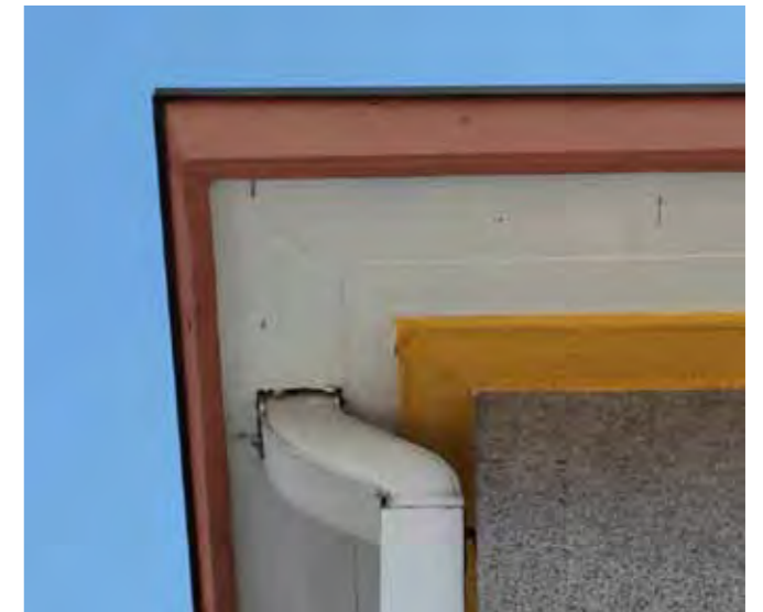
Räystäään nurkissa muottilaudoitusta on ollut jiirattu ja syöksytorvelle on tehty läpivienti.
