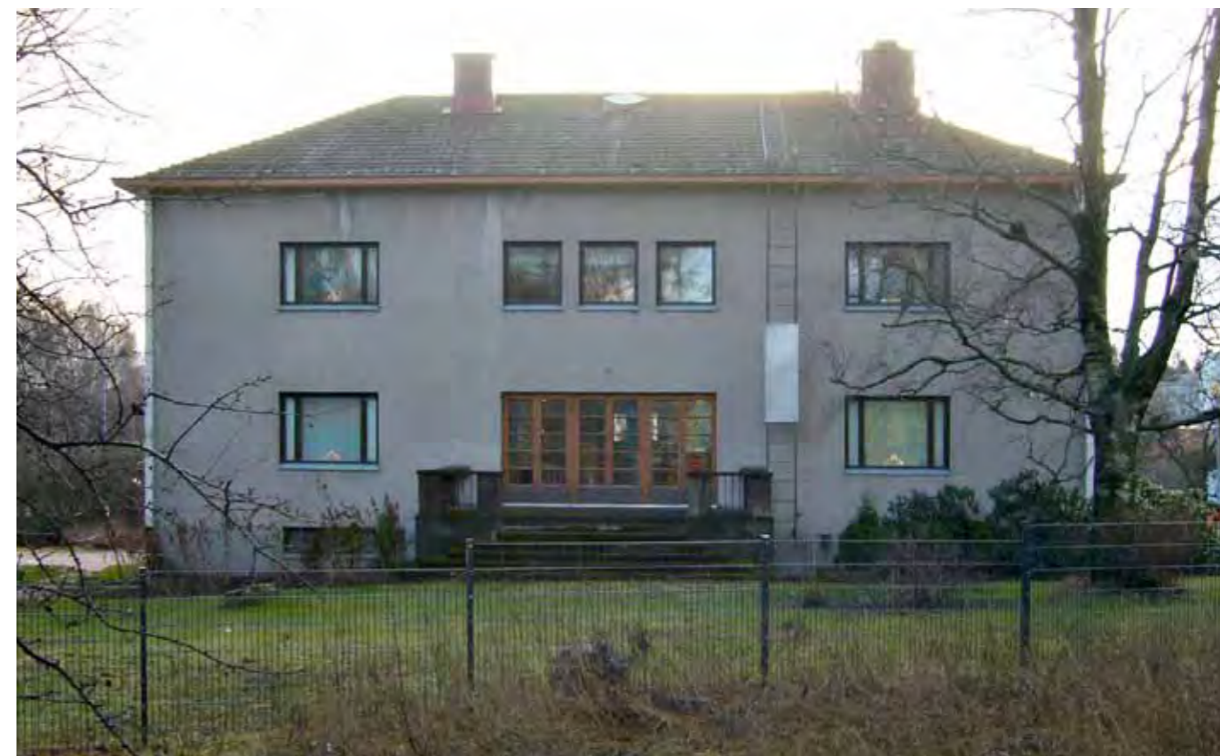
Rakennuksen pohjoisjulkisivun lasiovet ovat ainoat alkuperäisinä säilyneet ulko-ovet.
