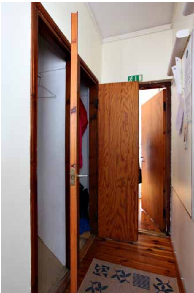
Y/1 Lounaisnurkan makuuhuoneesta halliin johtavan pienen käytävän varrella on rakennuksen ainoat säilyneet kiinteät komerot. Komeroiden pohja on kalteva alla olevan portaan takia.
