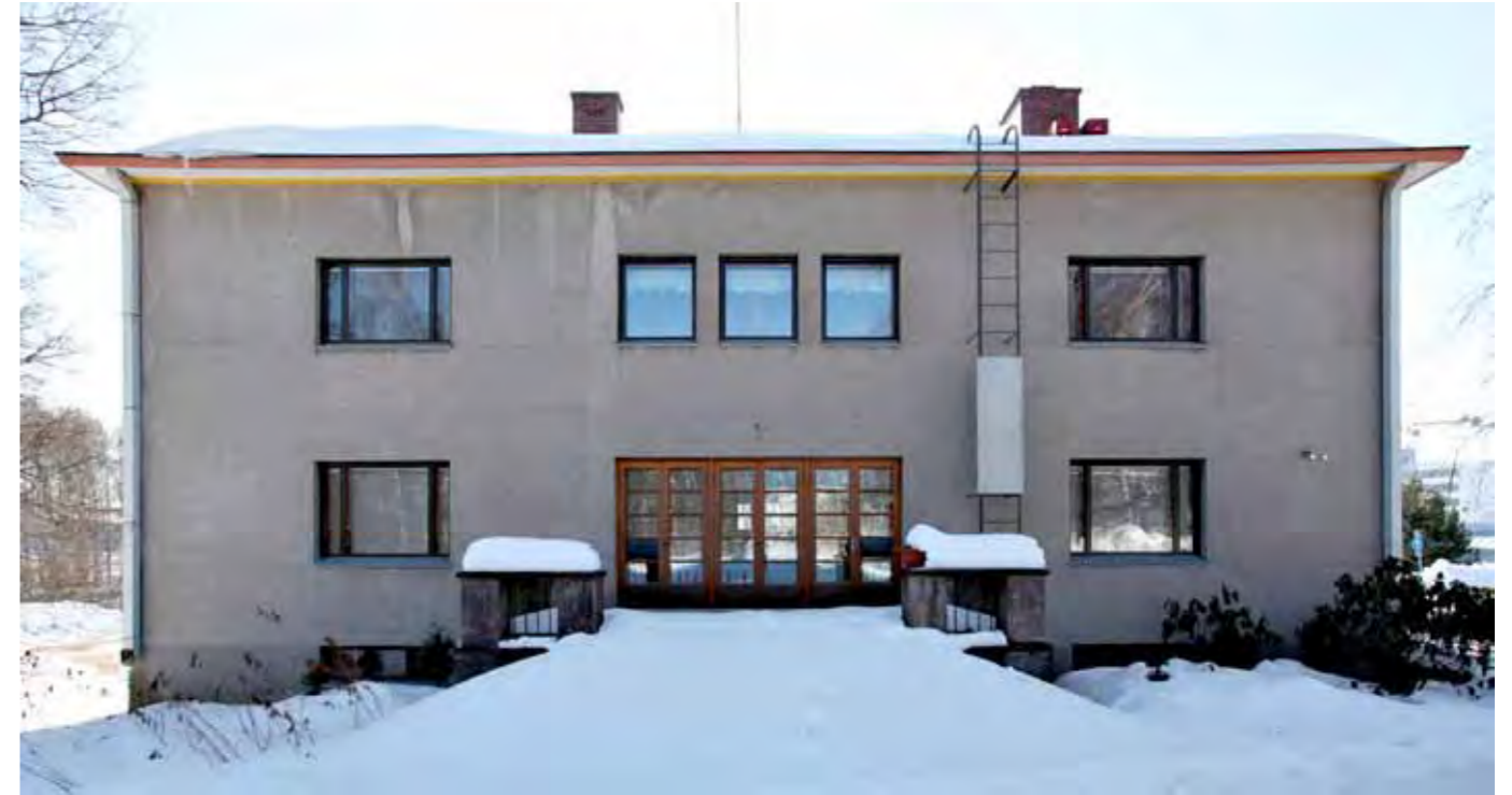
Rakennuksen pohjoisjulkisivu on säilynyt parhaiten alkuperäisessä asussa.
