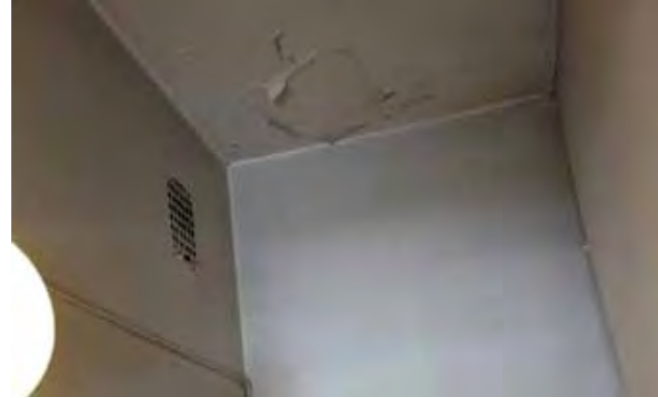
Poistoilmaventtiili keittiön portaan seinässä.
