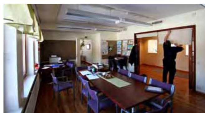
Y/3 Yläkerran huoneen ("rum") ja hallin välissä on liukuovet. Entiseen makuuhuoneeseen johtava oviaukko on puhkaistu vuonna 1986. Aukkoon on 2000-luvulla asennettu ääneneristysovi (Kaarlo Ahlstedt, haastattelu).
