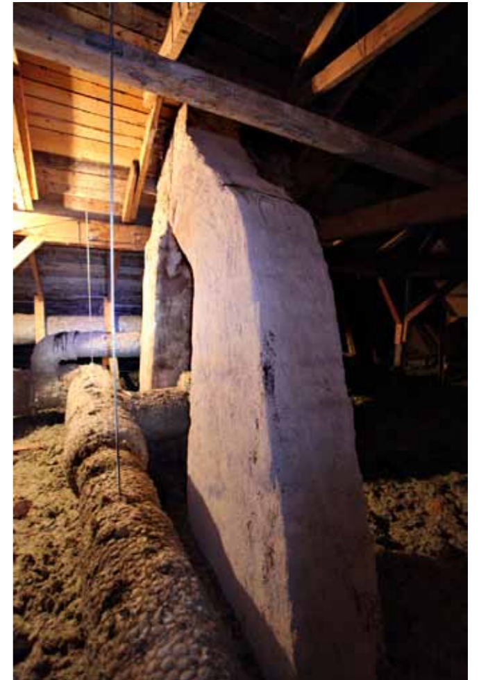
Alakerran hallin avotakan hormi liittyy vintillä itäiseen savupiippuun.
