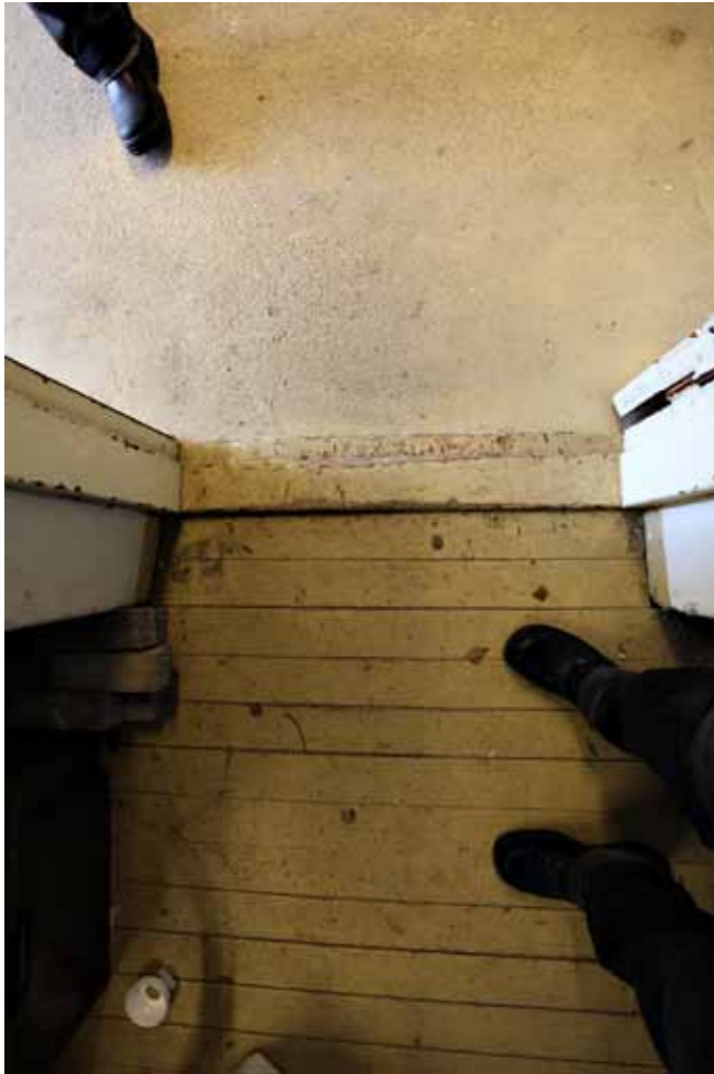
Alapohjan pintamateriaalina on maalattu betoni. Verstahuoneessa on kuitenkin ponttilautalattia. Maalattut puulattiat maalattiin vuonna 1986 Permo-maalilla. (Mattby Gård, Peruskorjaus, Rakennusselitys 1986, Arkkitehtitoimisto Ville Wegelius ky.)
