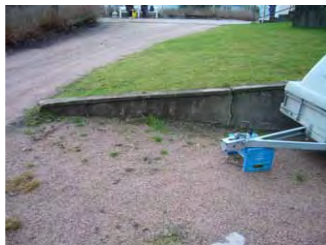
Halkeillut betoninen tukimuuri on rakennettu uuden päärakennuksen kanssa samaan aikaan.
