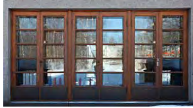
D/1 Pohjoissivun terassille johtava lasiovisto on arvokas alkuperäinen rakennusosa.
