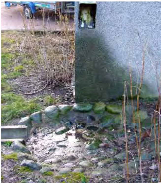
Koillisnurkkaan on tehty syöksytorven alle roiskeallas. Rakennus on salaojitettu vuonna 1998 (Espoon kaupunki, Tehdyt työt 1986–2011).
