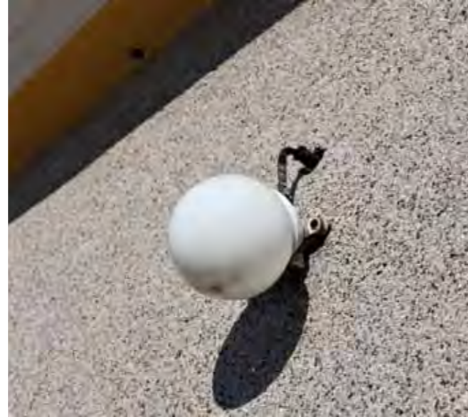
Eteläparvekkeen oven päällä lieenee alkuperäinen pallovalaisin. Myös muiden ulko-ovien päällä on ollut valaisimet, jotka ovat mahdollisesti olleet samaa tyyppiä.
