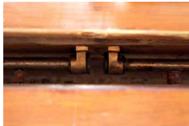
D/5 Liukuovien alkuperäiset liukuhelat ovat säilyneet.
