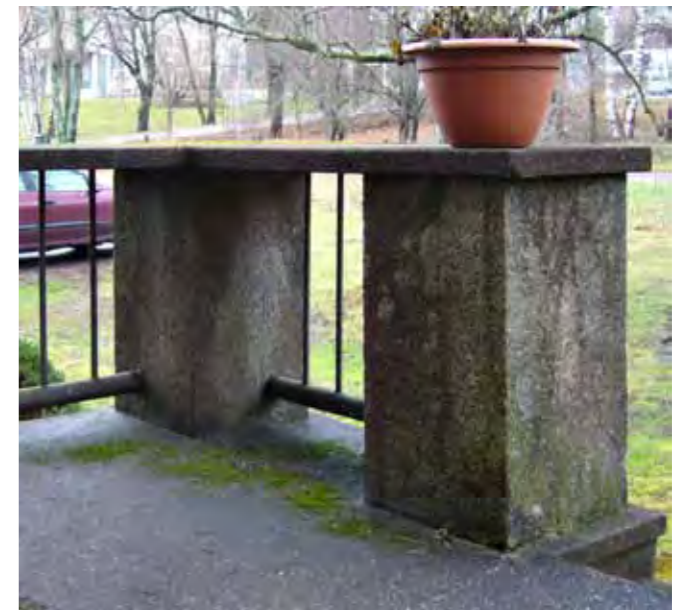
Pohjoissivun terassin betonikaiteet on terastirappattu.
