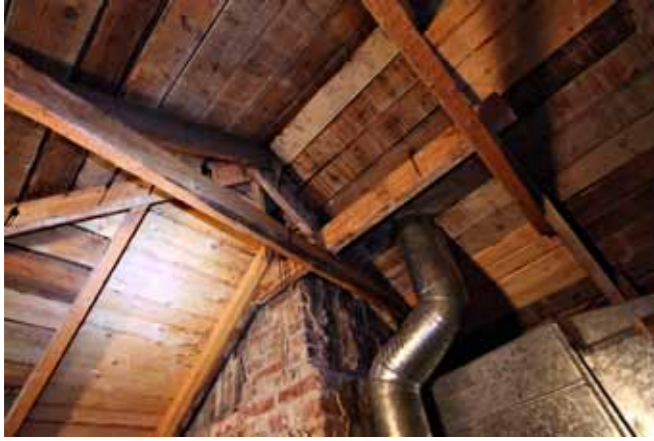
Eristetty läpivienti läntisen savupiipun kyljessä lienee viemärintuuletusputki. Savupiipun yläosa on muurattu uudelleen.
