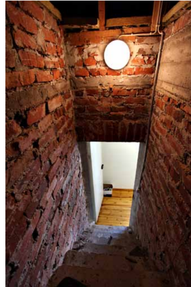
Vintin portaan oviaukon yläpuolinen seinä on kannatettu tiiliholvilla. Oikeanpuoleisessa seinässä näkyy välipohjan primääripalkki.
