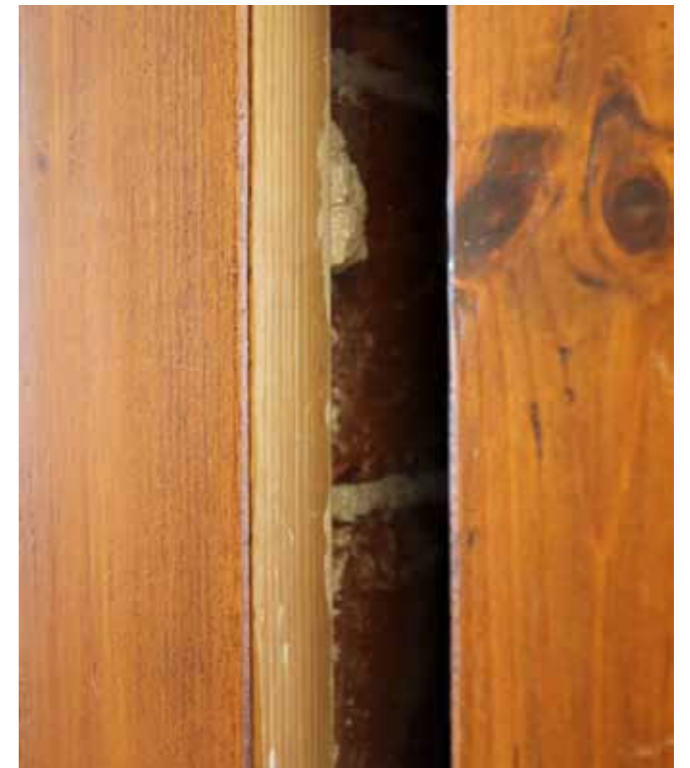
Liukuoviseinät on muurattu syrjätiilestä.
