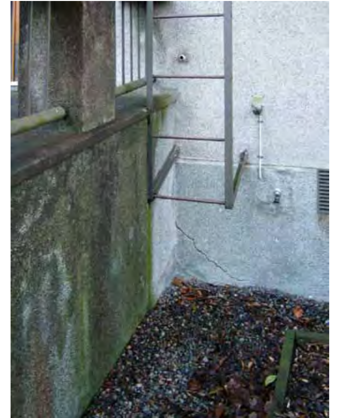
Rakennuksen sokkeli erottuu muusta seinäpinnasta rappauspinnan jäsenöinnillä. Rakennus on sala-ojitettu vuonna 1998 (Pentti Oirola, puhelinhaastattelu 22.3.2012).
