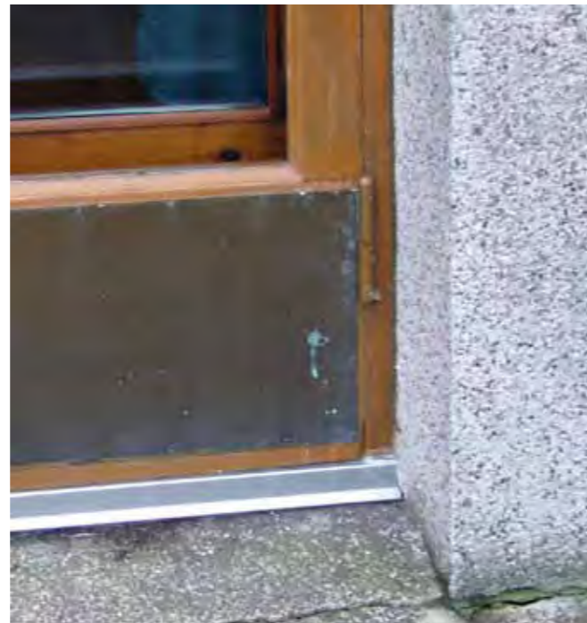
D/1 Oven alaosaan on tehty vedeneristyskorjaus vuonna 2000 (Espoon kaupunki, Tehdyt työt 1986–2011).
