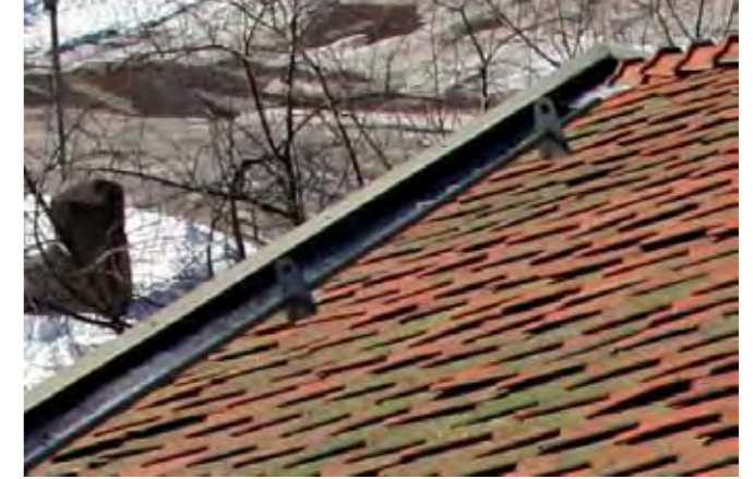
Punainen savitiilikate lienee alkuperäinen. Vesikatto on varustettu alkuperäisellä räystäääseen upotetulla räystäskourulla ja myöhemmin asennetulla lumiesteellä.
