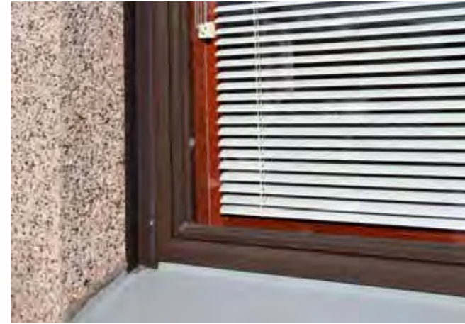
Ikkunarakenteet ovat ulkopuolelta kokonaan metallipintaisia. Perinteisesti ikkunankarmi on osittain rappauksen sisäpuolella. Uusituissa ikkunoissa karmien ja rappauksen väliin on jätetty rako, joka on peitetty listoilla ja elastisella massalla. Samalla valoaukko on pienentynyt.
