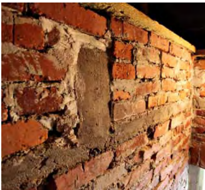
Alalaattapalkiston profiili näkyy vintin portaan seinässä.
