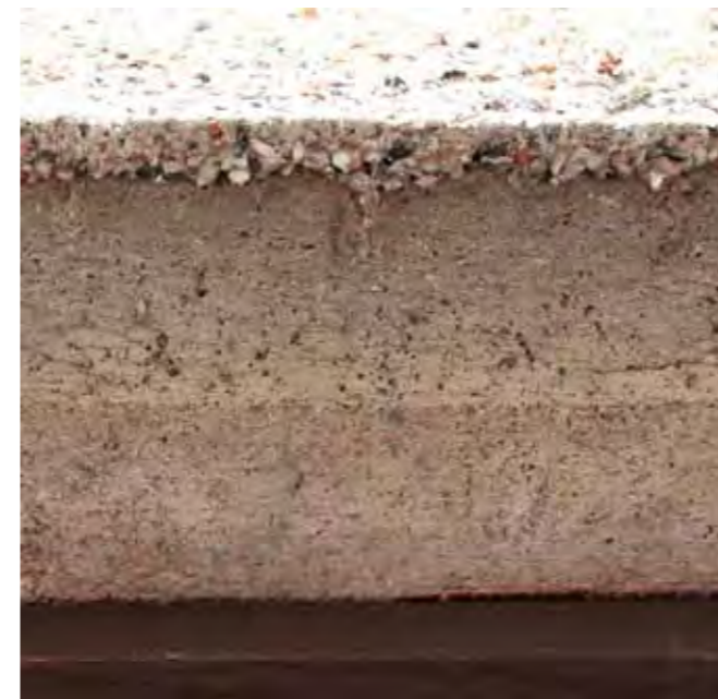
Ulkoseinien aukkojen ylitykset on tehty teräsbetonipalkeilla.
