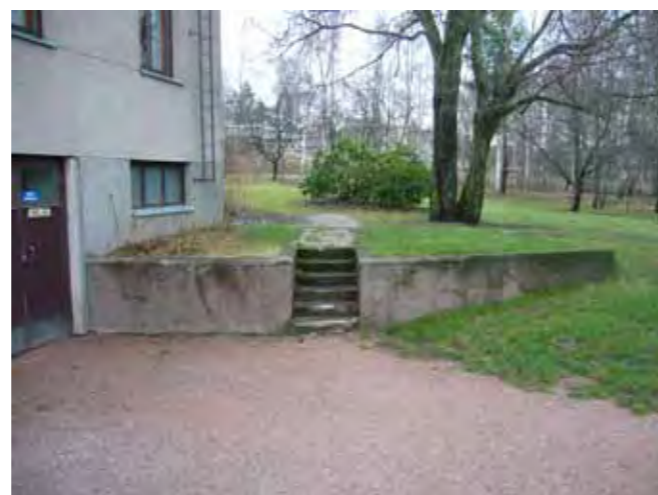
Betoninen tukimuuri portaineen on rakennettu uuden päärakennuksen kanssa samaan aikaan.
