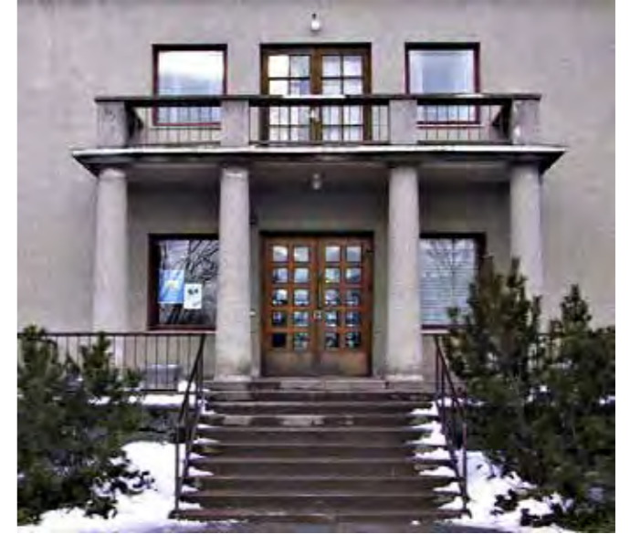
Kartanon pääsisäänkäynti vuonna 2001. Lasitetut puuovet ovat tärkeä osa alkuperäistä arkkitehtuuria. (Kuva: Espoon kaupunki, Tekninen keskus)
