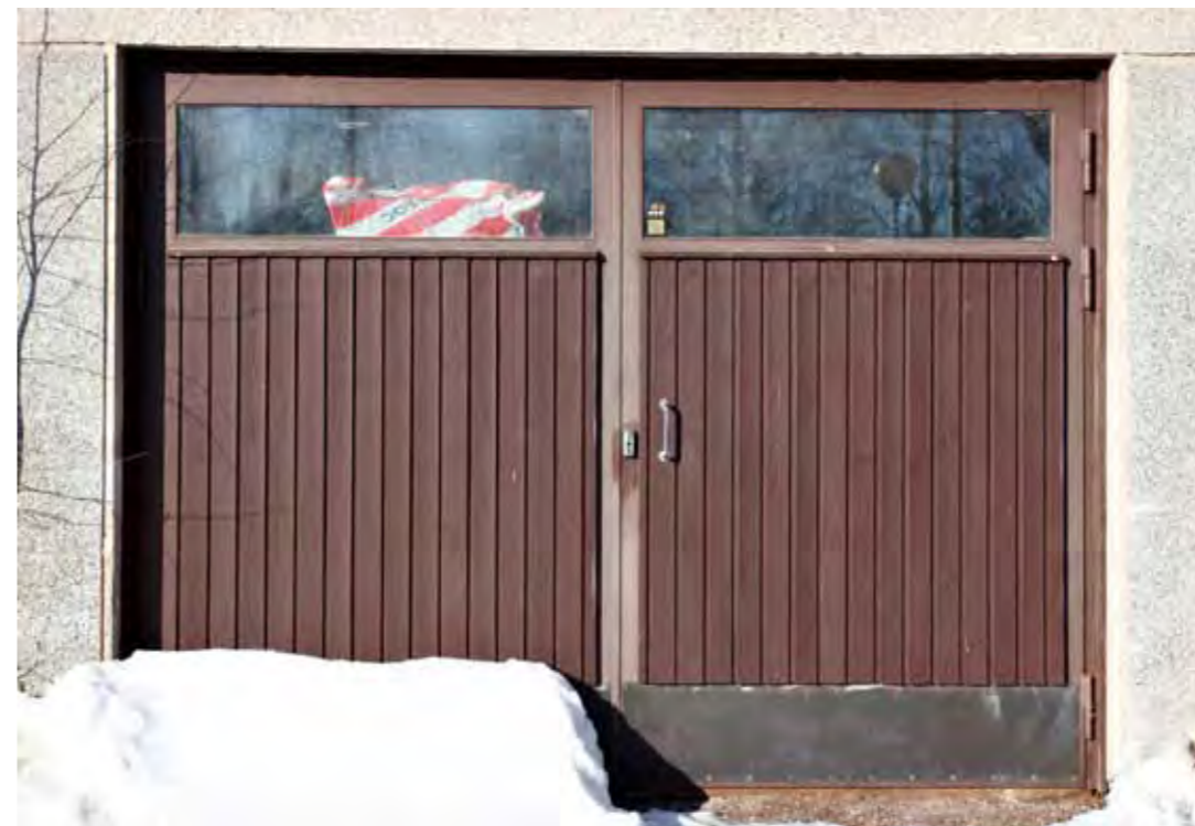
D/3 Autotallin ovet saattavat olla rungoltaan alkuperäiset. Lasit on vaihdettu umpiolaseiksi ja panelointi on uusittu. Paneloinnin uusimisesta on maininta vuodelta 2008 (Espoon kaupunki, Tehdyt työt 1986–2011).
