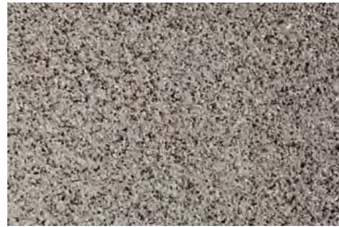
Ruskehtavassa rappauspinnassa on valkoisen, harmaan ja mustan kiven lisäksi tiilimurskaa.
