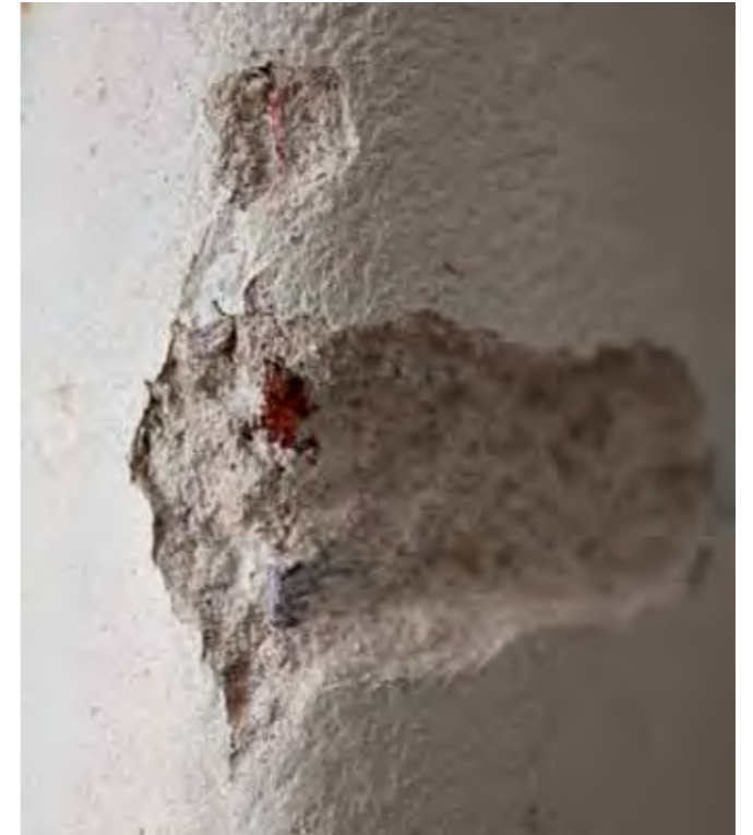
Kellarin ulkoseinän sisäpinta rakennuksen itäpäädyssä on tehty tiilestä muuraamalla.
