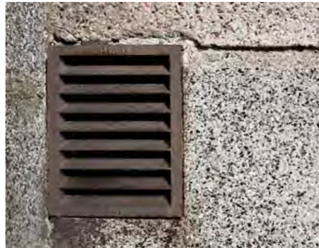
Kellarin valurautainen korvausilmasäleikkö. Muissa kerroksissa ei ole korvausilmasäleikköjä. Raitisilma on ilmeisesti otettu sisään ikkunoiden kautta.
