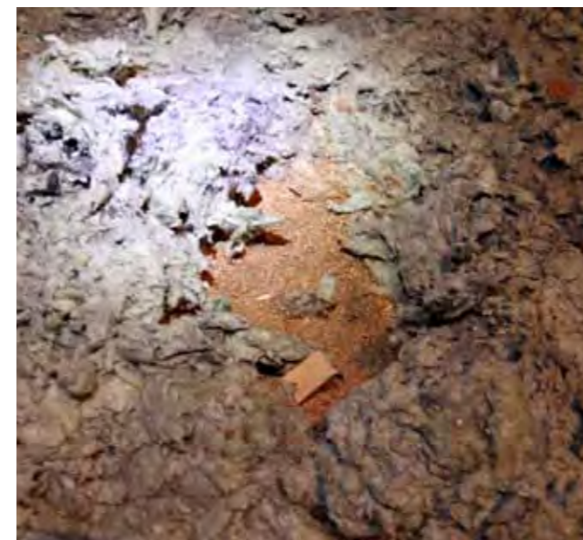
Yläpohjan täyteenä on sahanpuru, jonka päälle on vuonna 1986 laitettu mineraalivillaa. Espoon kaupungilla on varattuna rahaa yläpohjan lämmöneristyksen parantamiseen vuonna 2012.
