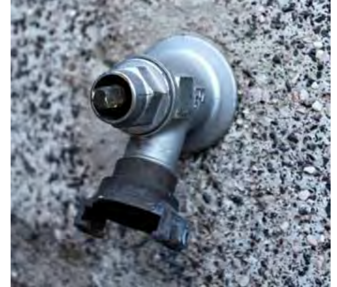
Vesiposti pohjoisseinässä talotikkaiden alapäässä.
