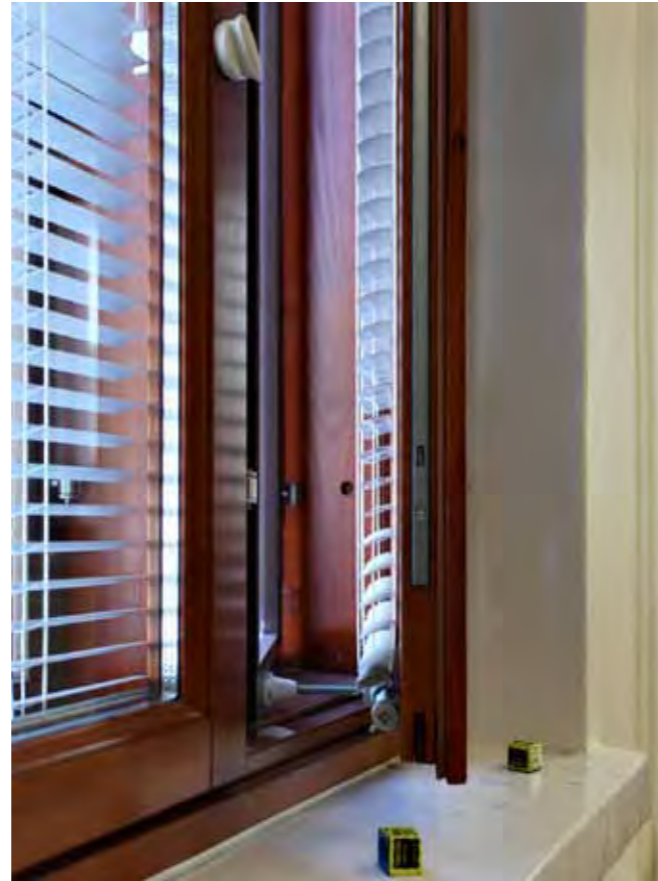
Sisäpuolelta ikkunat ovat puuta. Umpiolasien ja tiiviin rakenteen vuoksi uudet ikkunat lienevät edeltäjiään energiatehokkaampia ja niiden ääneneistyskyky on parempi.
