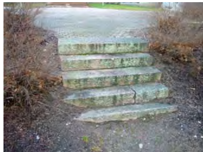
Graniittiset portaat ovat vanhan päärakennuksen aikaiset.
